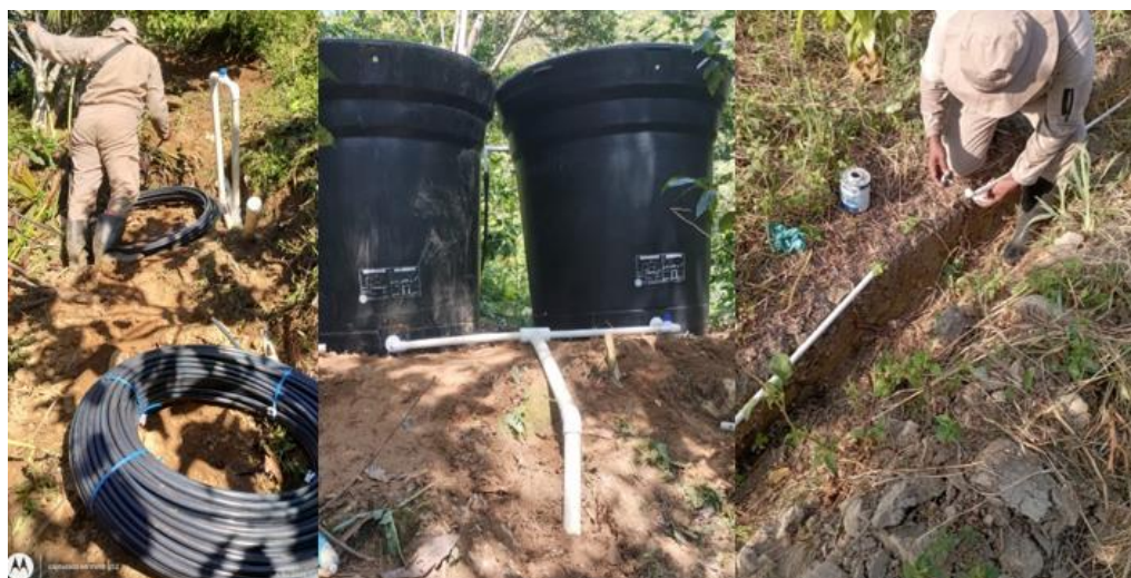
Figura 3. Instalación de sistema de riego por goteo parcelas sistemas agroalimentarios.
