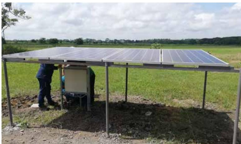
Figura 18. Pozo de captación de agua subterránea y bombeo con paneles solares CI Turipaná.
