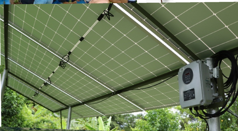
Infraestructura de energía solar, conformada por paneles que impulsan bombas para el suministro de agua en cultivos de sachu inchi. Foto: Liseth Cárdenas.
