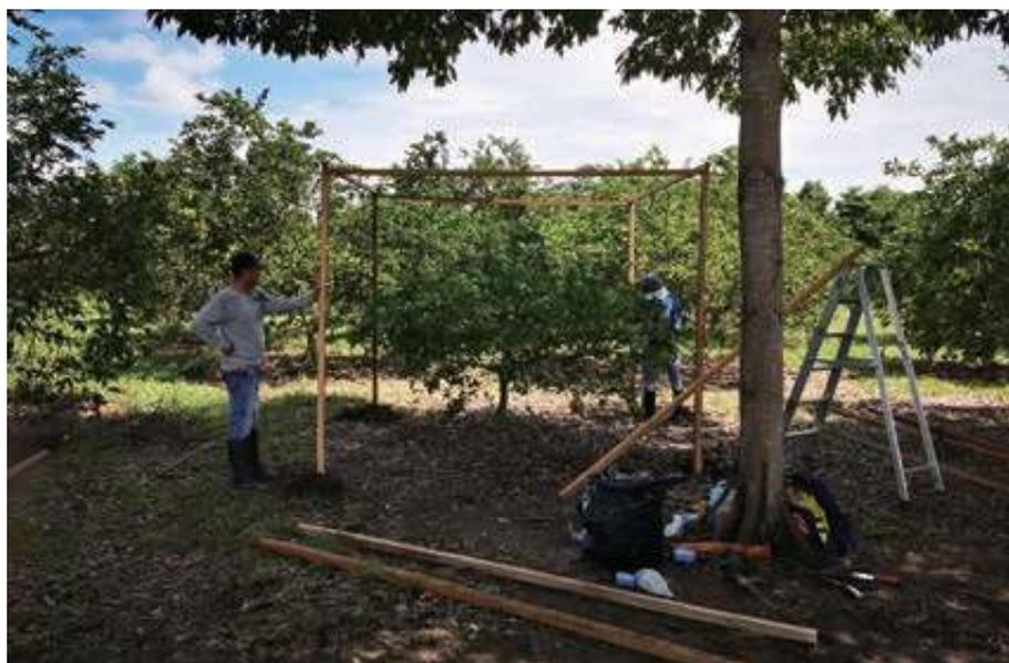
**Figura 29. |** Colocación de los parales laterales.
