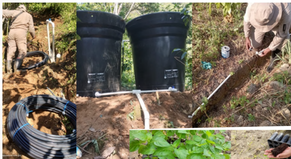
Figura 3. Instalación de sistema de riego por goteo parcelas sistemas agroalimentarios.
